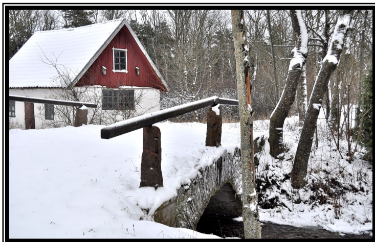
Gamla landsvägen över ån
